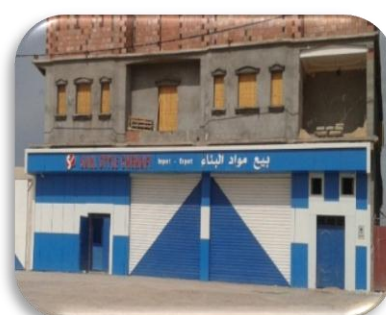
صورة 32 : بيع مواد البناء المصدر: من إعداد الطالب 2016/04/21.
