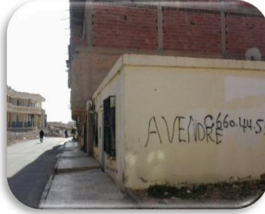
صورة 46 : سكن تطوري المصدر: من إعداد الطالب 2016/04/21.
