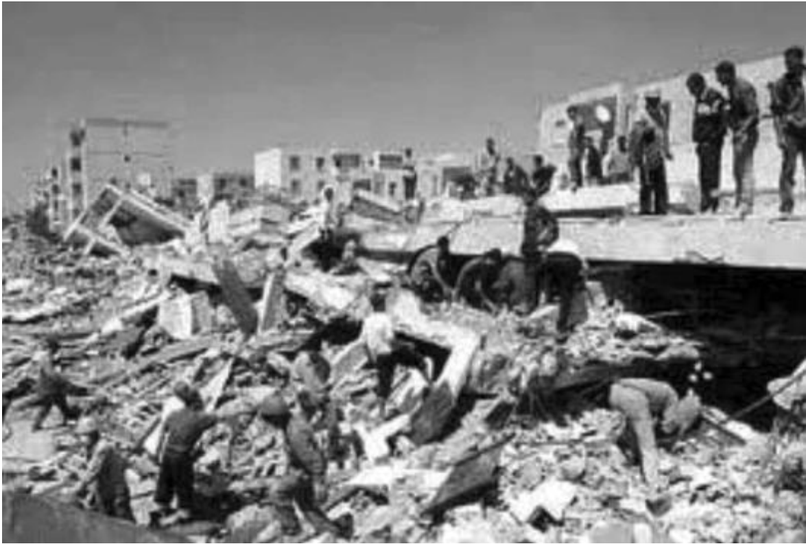
Figure I.9. Bâtiments RC endommagés par les récents séismes Ain Temouchenet 1999 et Boumerdes 2003 [10].
