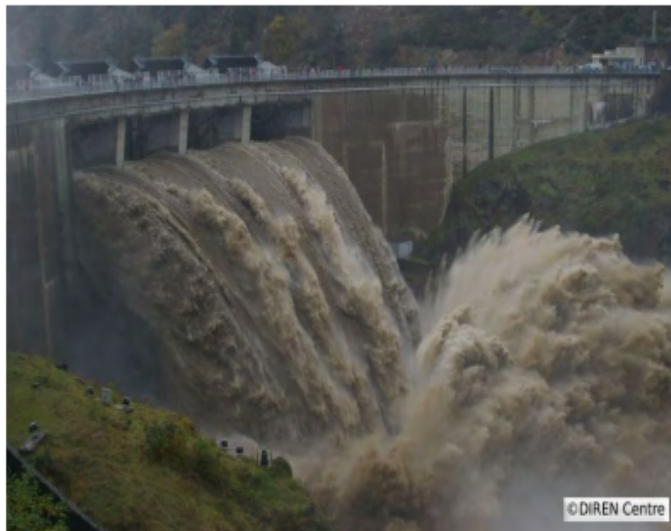
Crue de la Loire au barrage de Grangent en novembre 2008 : chute et ressaut hydraulique (régime rapidement varié)
