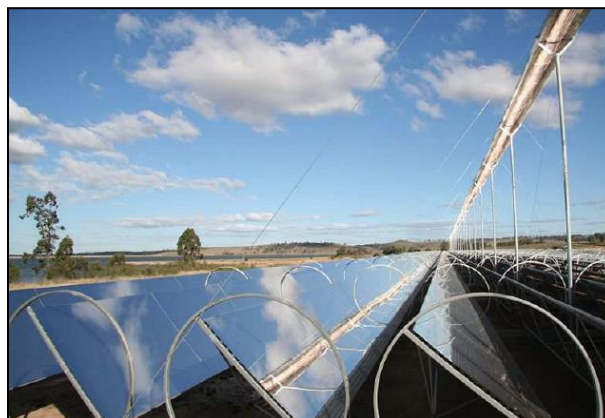
Figure I.9 : Concentrateur à réflecteur linéaire de Fresnel. [4]
