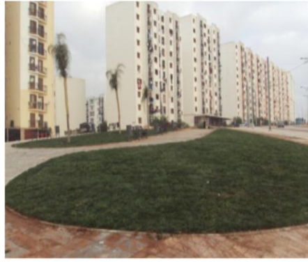
الصورة رقم (46): حي ايسطو
