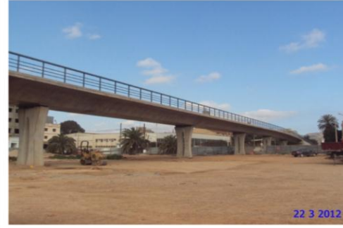
الصورة رقم(42): جسر الطريق 03 الجهة الشرقية
