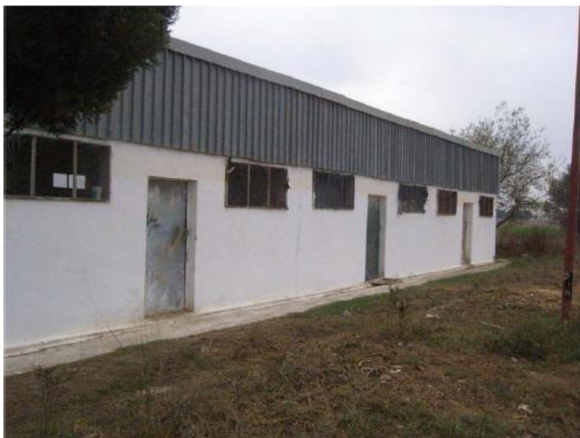
Figure 2 : Modèle de bâtiment d'élevage (ITELV, 2018).
