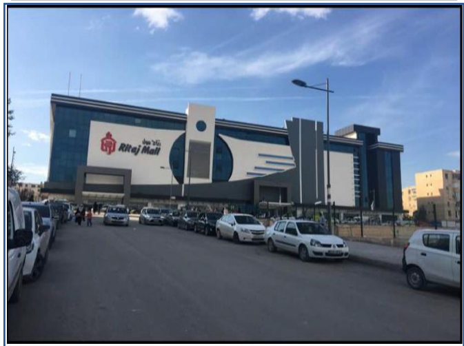
الصورة رقم (24) : المركز التجاري ريتاج مول
