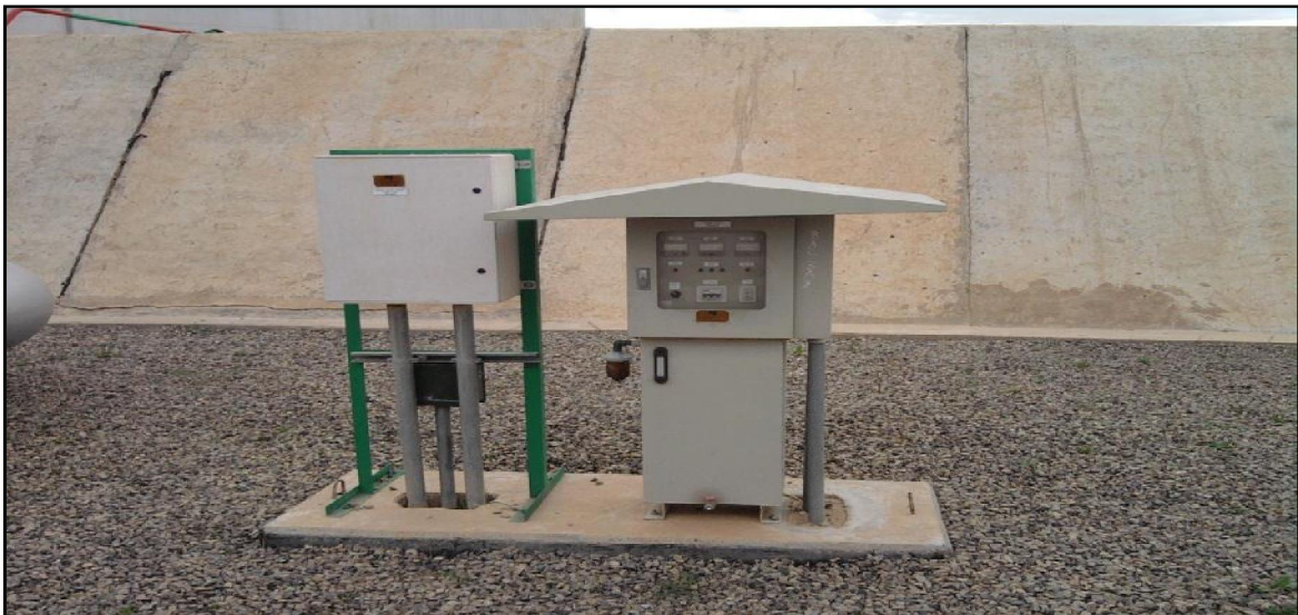
Figure III-9 : Poste de protection cathodique du bac 3A2.
