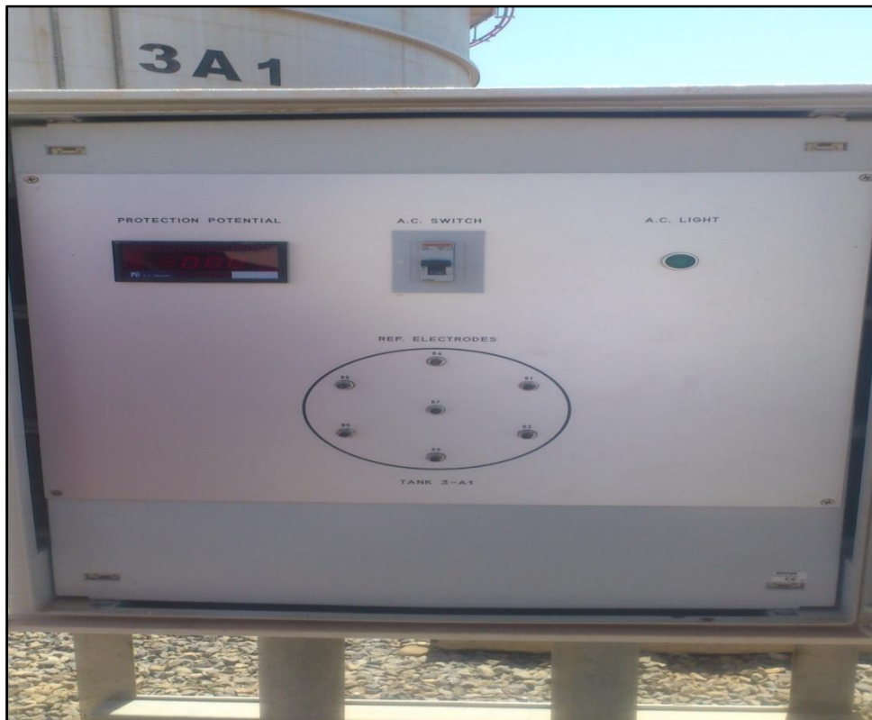
Figure III-11 : poste de contrôle de potentiel des anodes.
