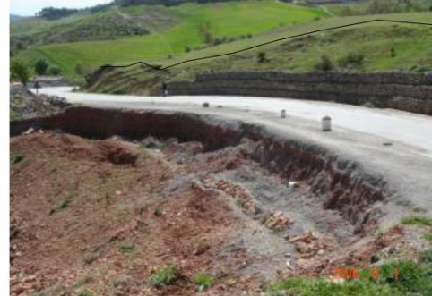
Travaux de confortement
