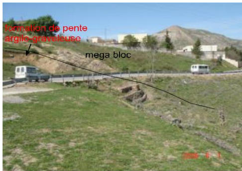
Glissement par ravinement
