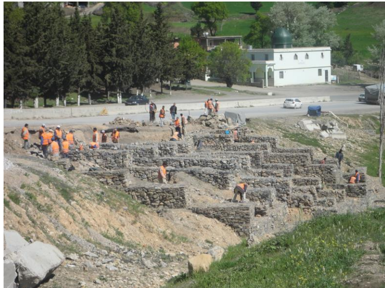
Photo VII.5 : déroulement des travaux de confortement
