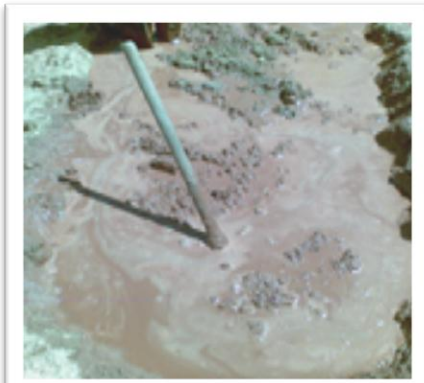
الصورة 100: المرحلة الثانية من البناء المصدر: جمع الطلبة 2013
