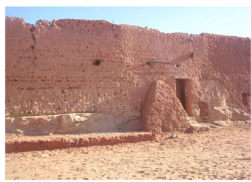
الصورة 87: صورة توضح الركيزة المصدر: التقاط الطلبة 2013
