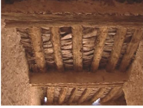
الصورة 104: صورة توضح مكونات السقف المصدر: التقاط الطلبة 2013
