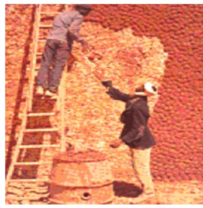
الصورة 105: صورة توضح عملية التلبيس للجدران الخارجية المصدر: جمع الطلبة 2013
