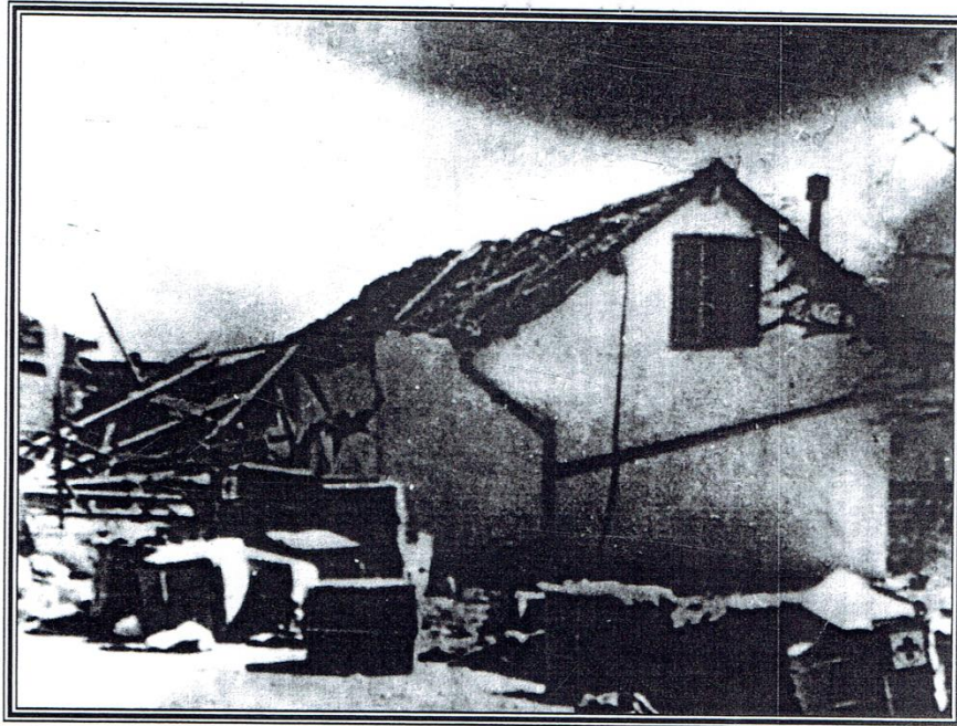
هذه المنازل قد تهدمت، وأزهقت تحتها أرواح الأبرياء، بقنابل الأعداء
