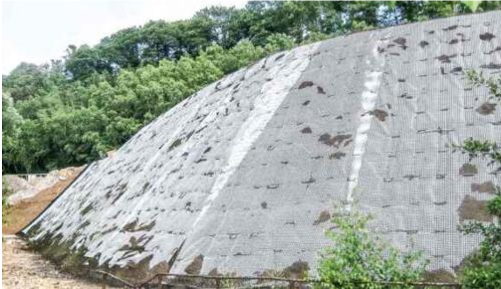
Figure I.8. Renforcement par géotextile
