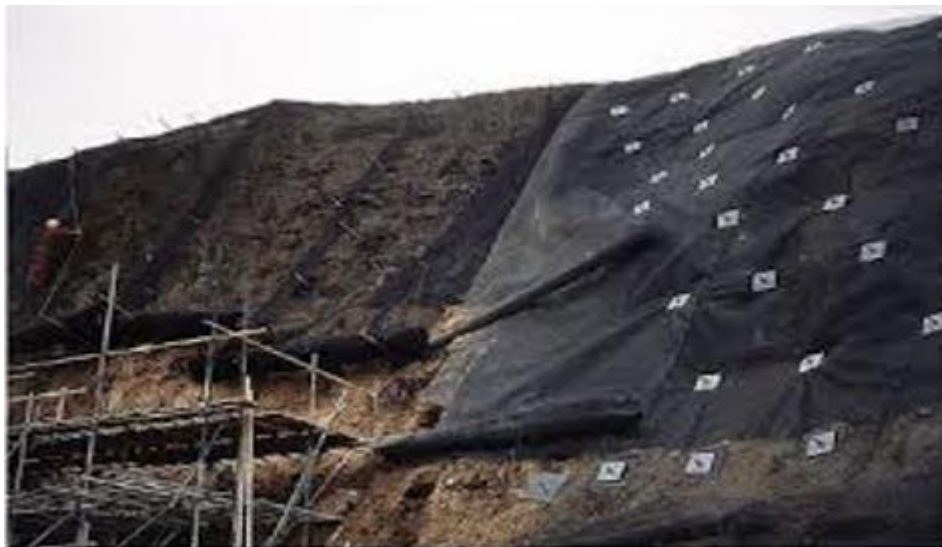
Figure I.7. Renforcement par clouage
