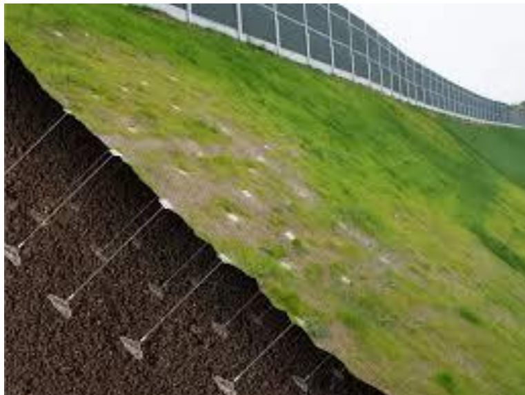
Figure I.9. Renforcement par végétalisation
