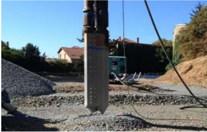
Figure I.6. Renforcement du sol par colonnes ballastées
