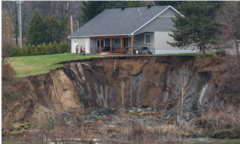
Figure III.12: Glissement de terrain.
