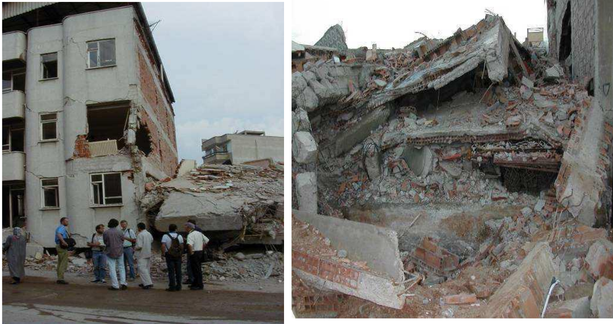
Figure III.5 : Effondrement d'un bâtiment sous forme d'une galette.
