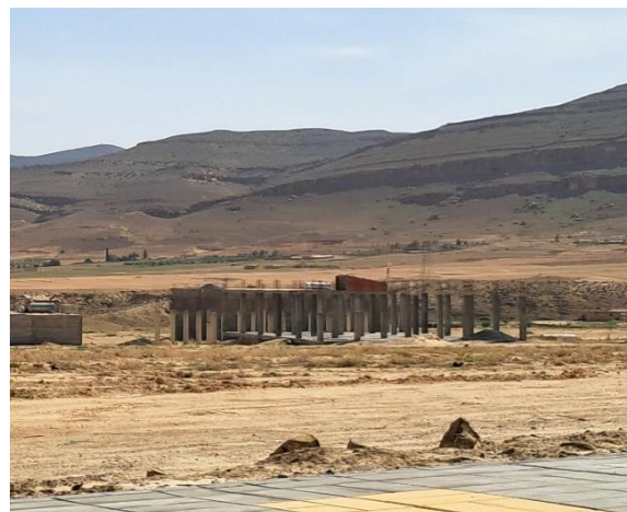
Figure 4 : habitat individuelle en construction (prise sur les lieux)
