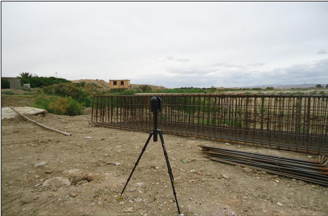
Figure III.5 : Photos des positions de l'emplacement du BLK360 pour obtenir une image complète du chantier de construction
