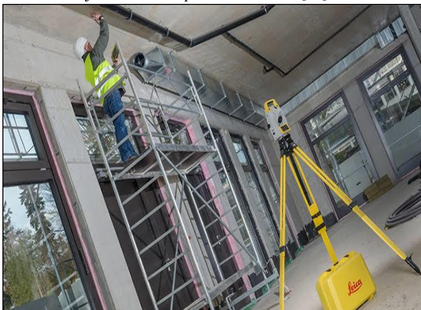
Figure I.20 : suivi des travaux [4]
