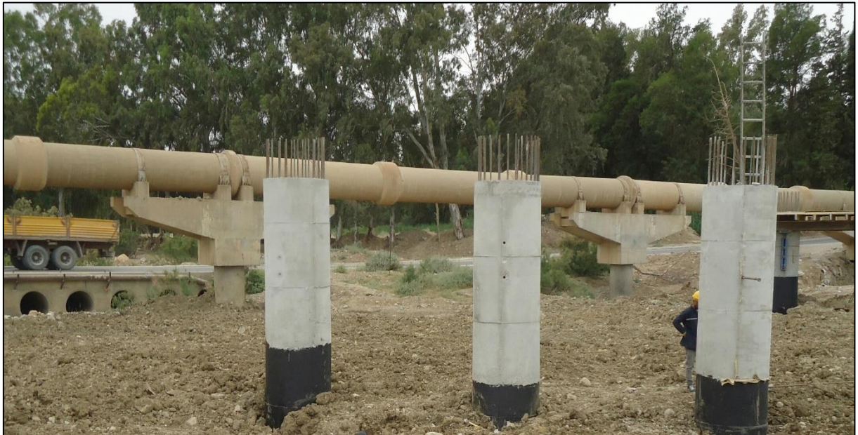
Figure III.1 : site des travaux Pont Sed Roumi de Ouled Bdeira
