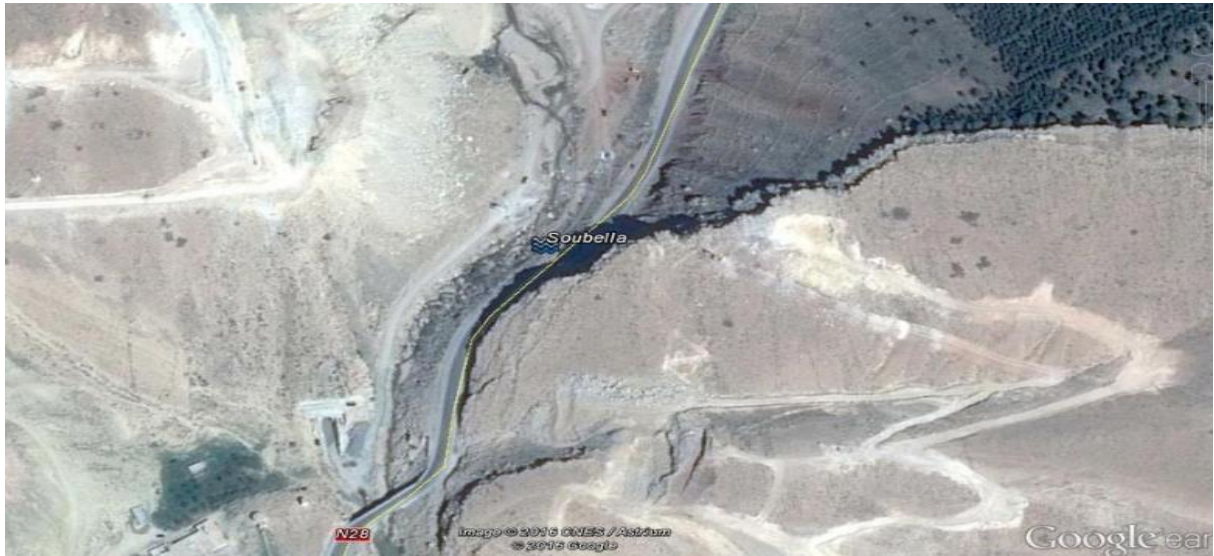
Figure III.1: Localisation géographique du barrage de SOUBELLA
