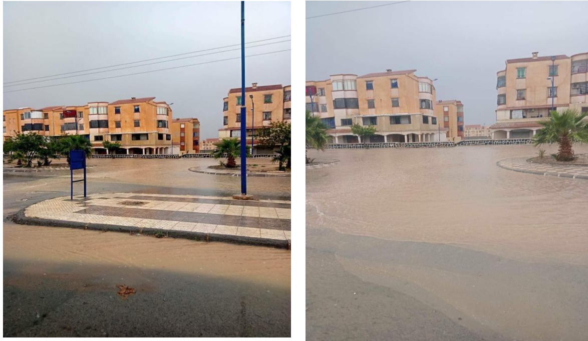
Figure 4.3 : Ouvrage annexes obstrués causant une stagnation des eaux Pluviales des pluies de ce mois de mai (29/05/2023)
