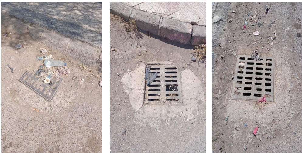
Figure 4.2 : Echantillon de bouches d'égout de la zone d'étude (02/05/2023)
