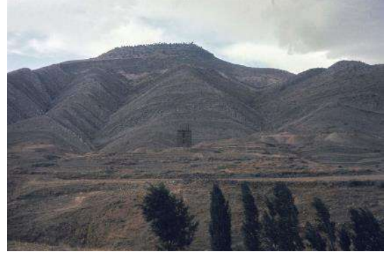
صورة رقم 17: صورة قديمة لمنذنة الجامع الكبير أثناء عملية الترميم
