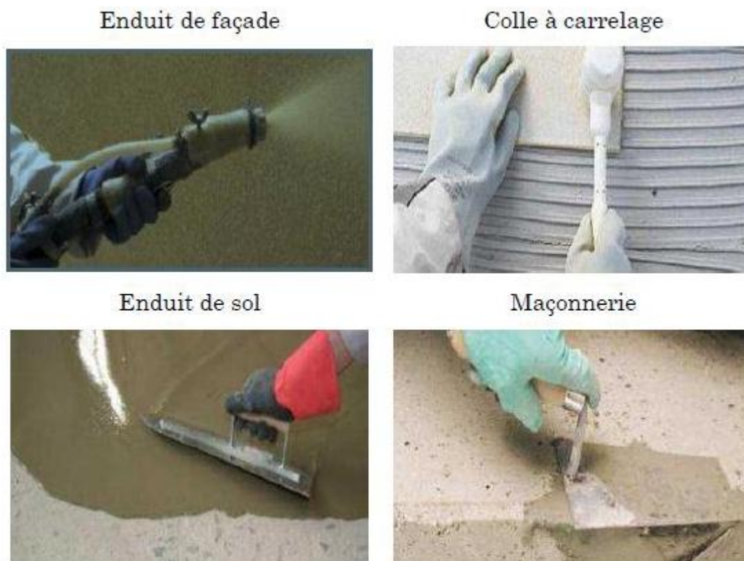
Figure (I.9) : Application des mortiers [17].
