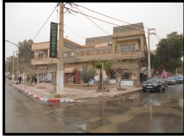
صورة رقم (07): توضح تركيب الواجهات في الحي
