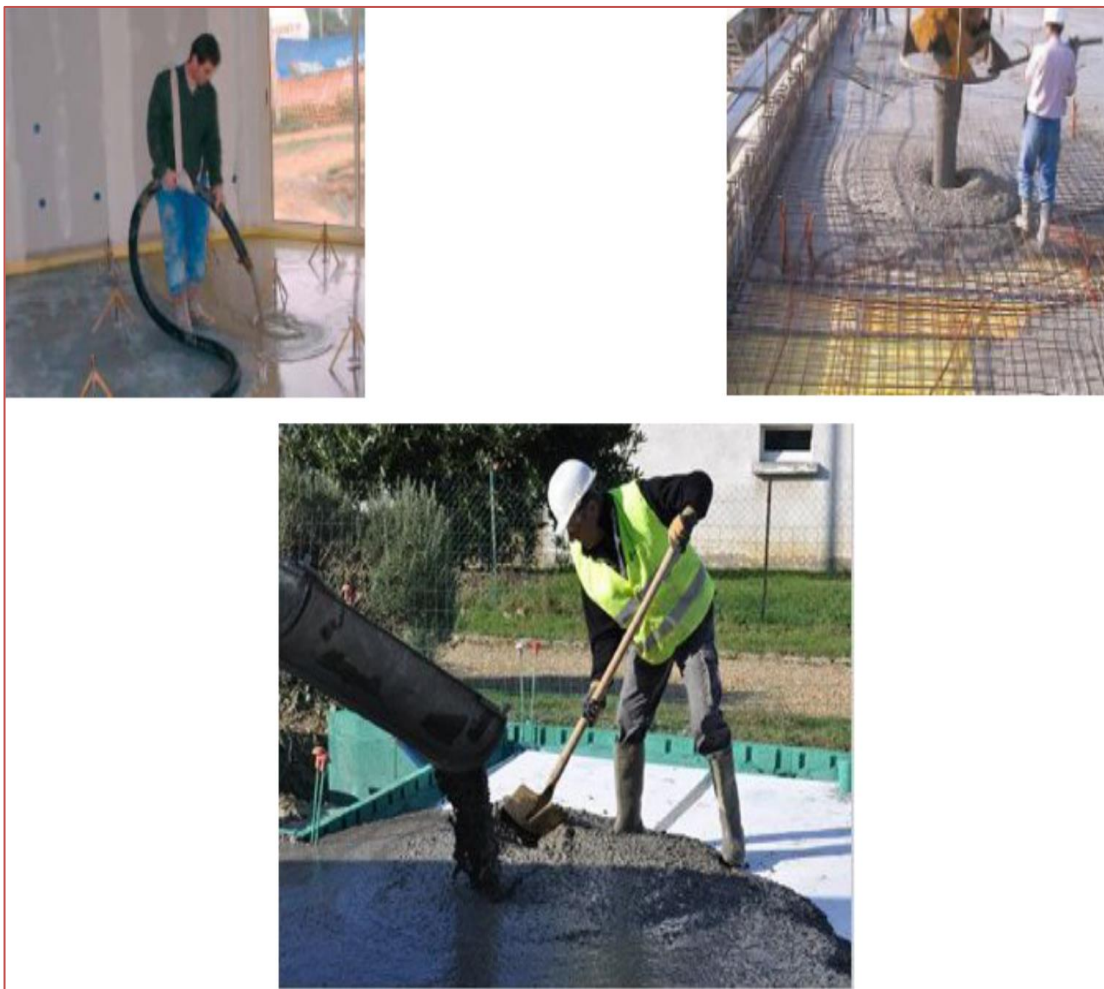
Fig. I-1-21. Mise en place aisée du BAP par un seul ouvrier. [16]
