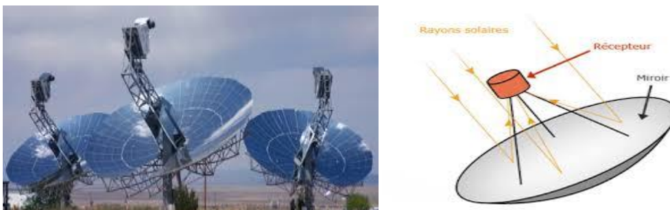
Figure I.6 : centrale thermodynamique parabolique.
