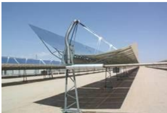
Figure I.8 : centrale thermodynamique cylindro-parabolique.
