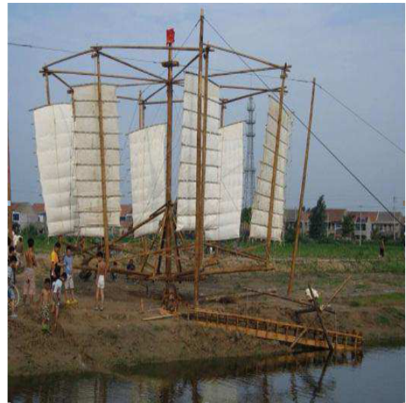
(b) Éolienne chinoise pour pompage d'eau.
