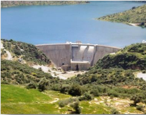
Figure 2.1. Barrage voûte de Tichihaf Béjaïa (Algérie) mis en service en 2005. Sa hauteur est de 84 m. (Tiré de : www.aghaladh.centerblog.net )
