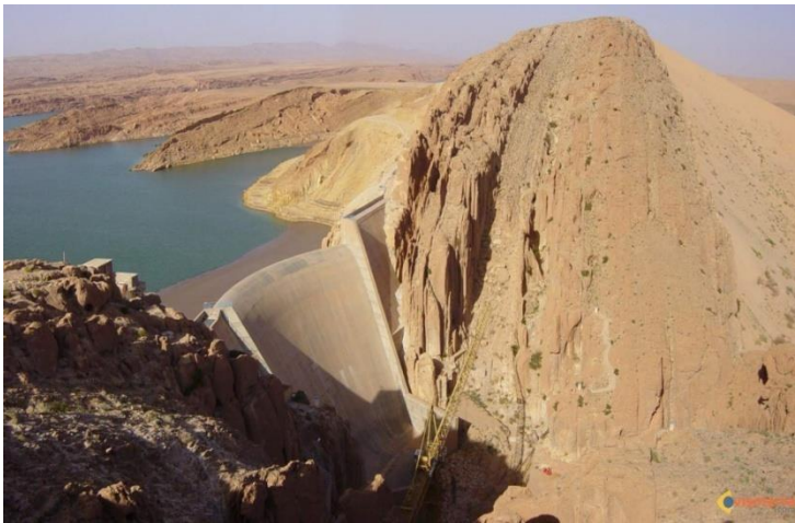
Figure 1.2. Barrage voûte de Brezina El bayadh (Algérie) mis en service en 2001. Sa hauteur est de 35 m. (Tiré de : www.visoterra.com )
