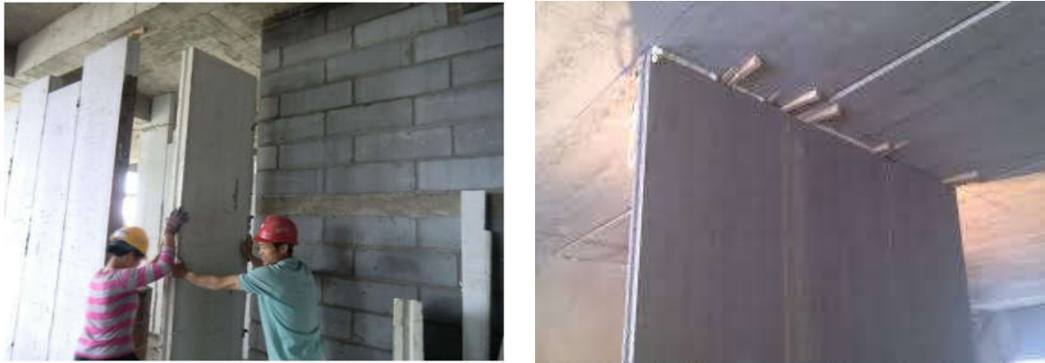
Fig. II.9: Quelques applications de béton polymère pour l'isolation.
