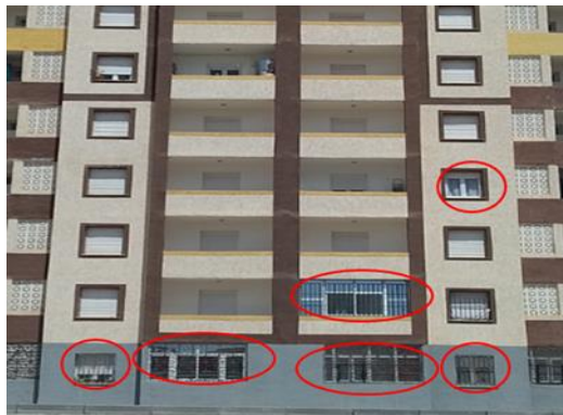
صورة رقم (38): توضح استعمال النوافذ الكابسة والمنزلقة
