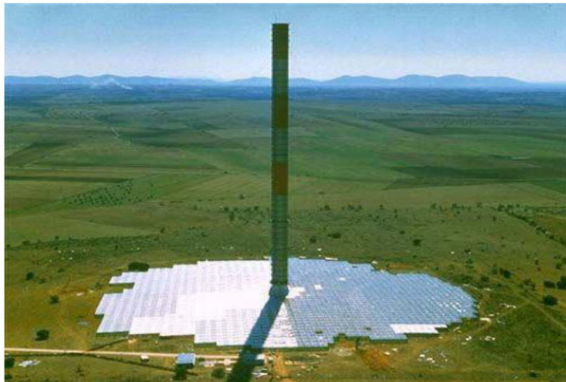
Figure 1.6 : Tour solaire implantée à Manzanares
