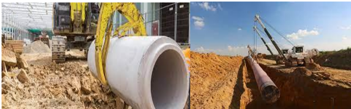
Figure 5.1: Pose de la canalisation d'assainissement.
