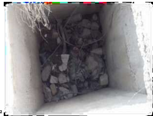
Fig III.2: Regard de vanne (remblai de terre est pierre)
