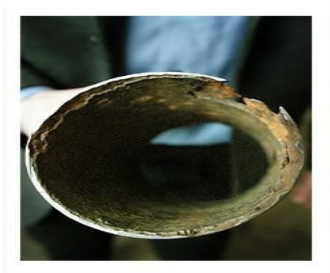
Figure I.2 : Une conduite ayant subi une rupture en Acier [4].
