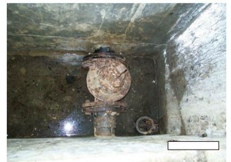
Fig III.4 : vanne Mauvaise état
