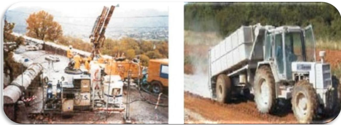
Fig. I.09: Traitement chimique à la chaux et au ciment.
