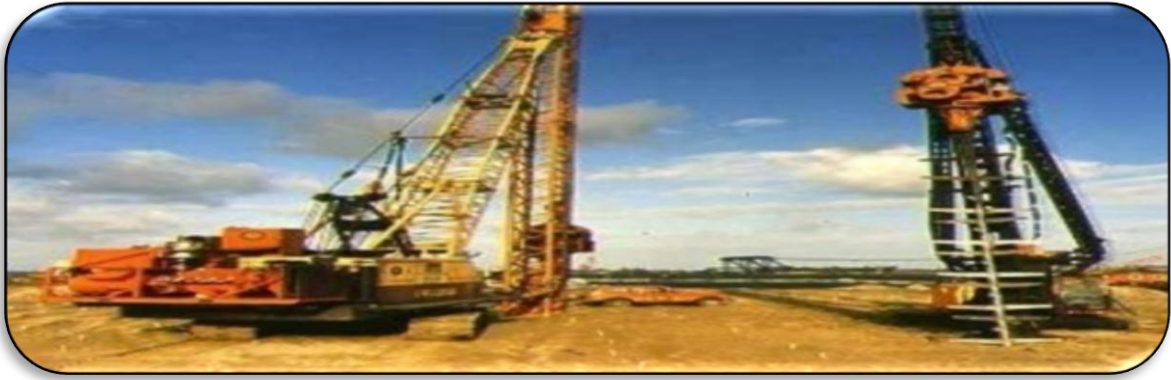
Fig. I.08 : Compactage par vitro-sonde.
