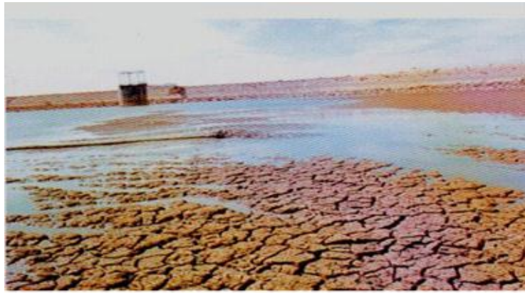
Figure 10: Envasement du barrage de BAKHADDA TIARET (2008)
