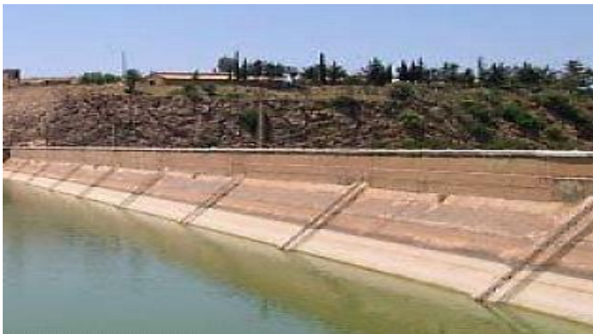
Figure 13: Surélévation de la digue du barrage de BAKHADDA
