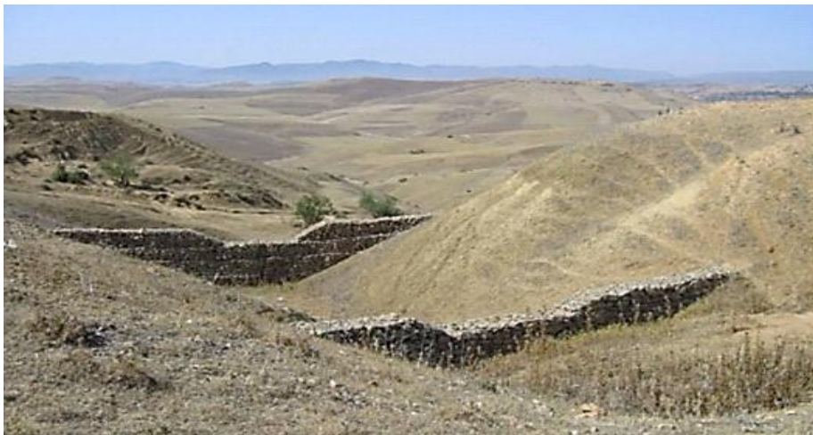
Figure 12: Corrections torrentielles dans la région de Tlemcen (Algérie). [B. MORSLI]
