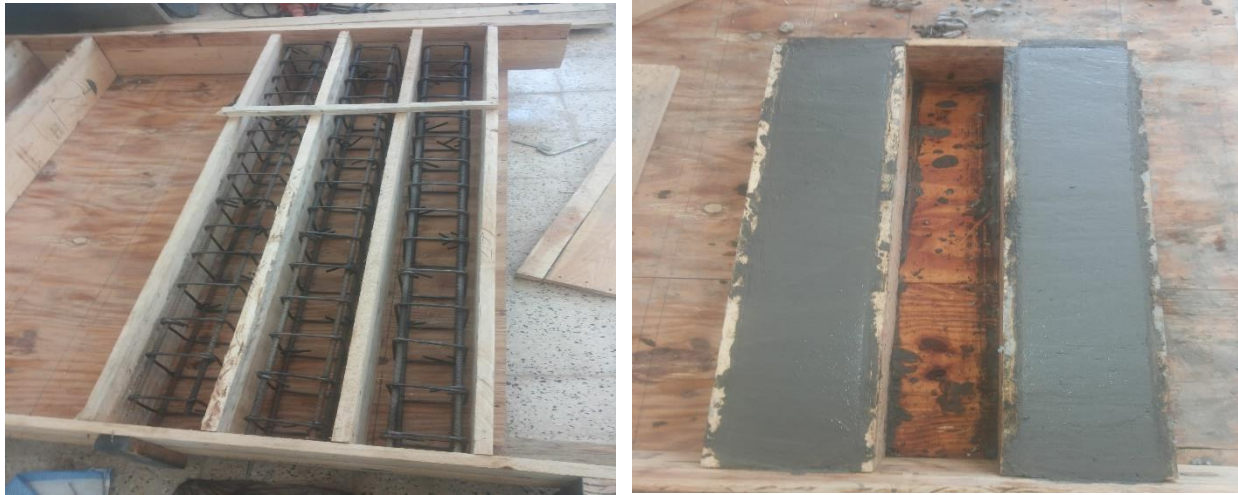
Figure (IV.4) : Protocole de fabrication et de coulage des poutres
