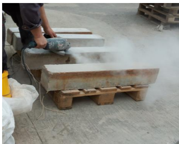
a : Préparation de surface par ponçage
