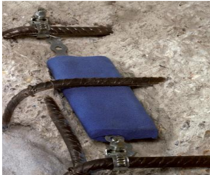
Figure (II-10) : Exemple d'une protection cathodique galvanique
