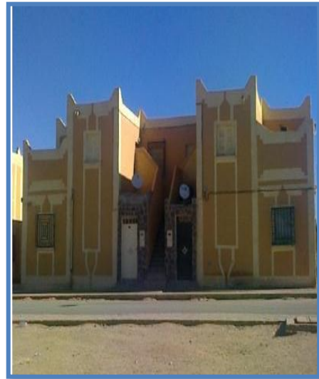
الصورة رقم (05): شكل البناءية
