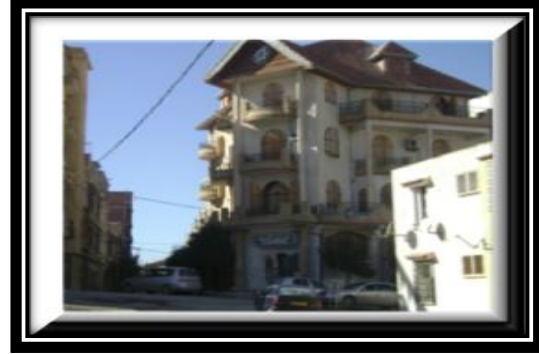
الصورة رقم 74: مبنى في حالة جيدة
