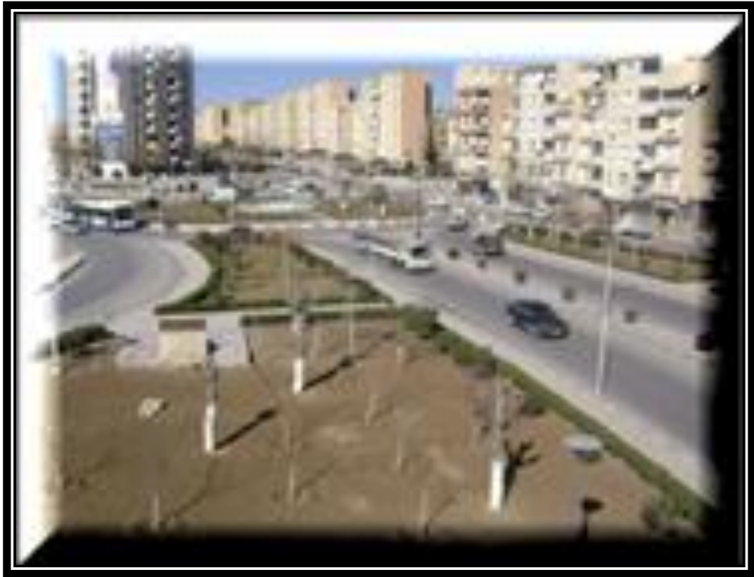
الصورة رقم 17: تهيئة الطريق الوطني رقم 05
