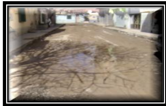
الصورة رقم 83: طريق ثاني في حالة سيئة
