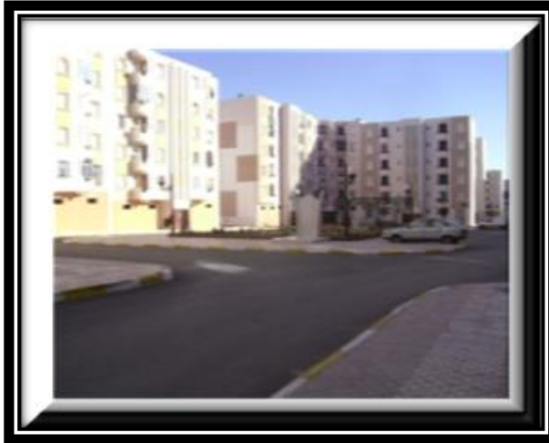
الصورة رقم 29: حي 400 مسكن
