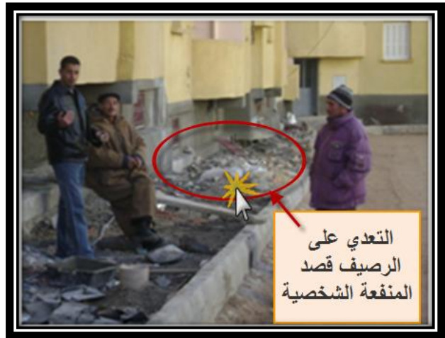
الصورة رقم 78: تمثل حالة البناء على الرصيف
