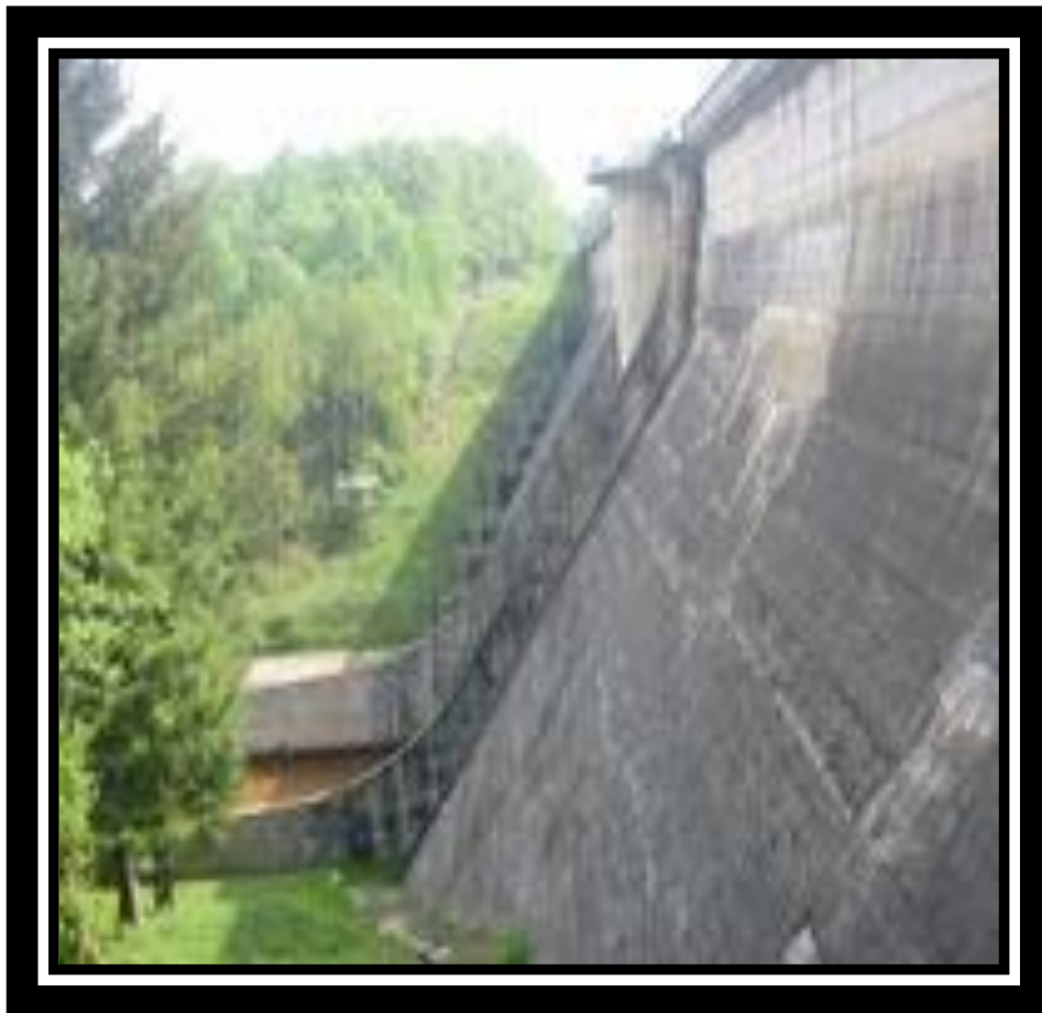
Fugger 1.2: Barrage d'Argentat
