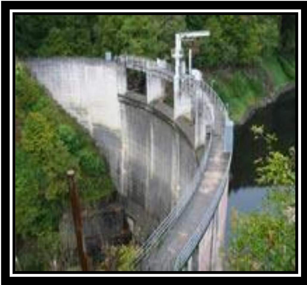
Figure 1.4 : Barrage de luzège.
