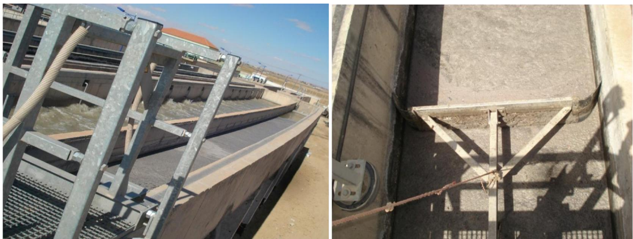
Photo II. 4: Dessableur/déshuileur et le pont racleur.
