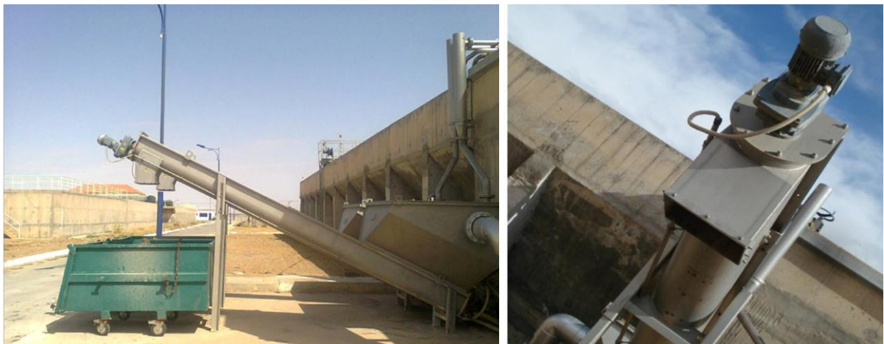
Photo II. 5: Mécanisme de l'extraction du sable.
