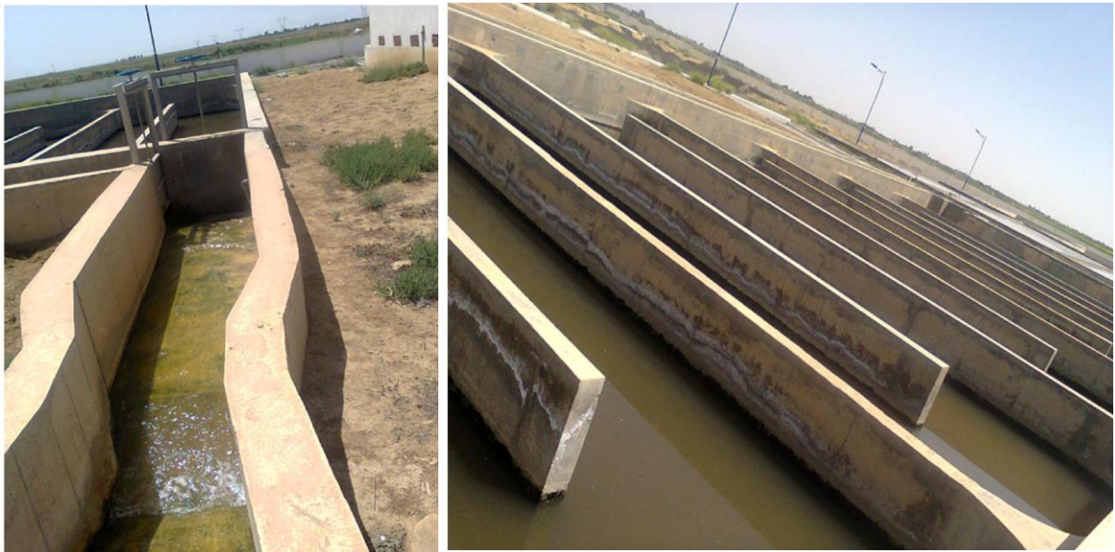
Photo II.11 : Bassin de chloration .
