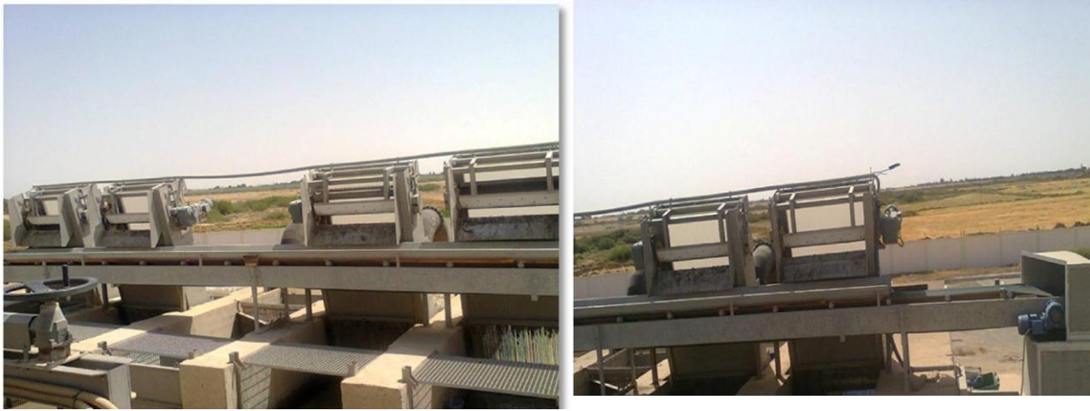
Photo II. 3: Les dégrilleurs fins.
