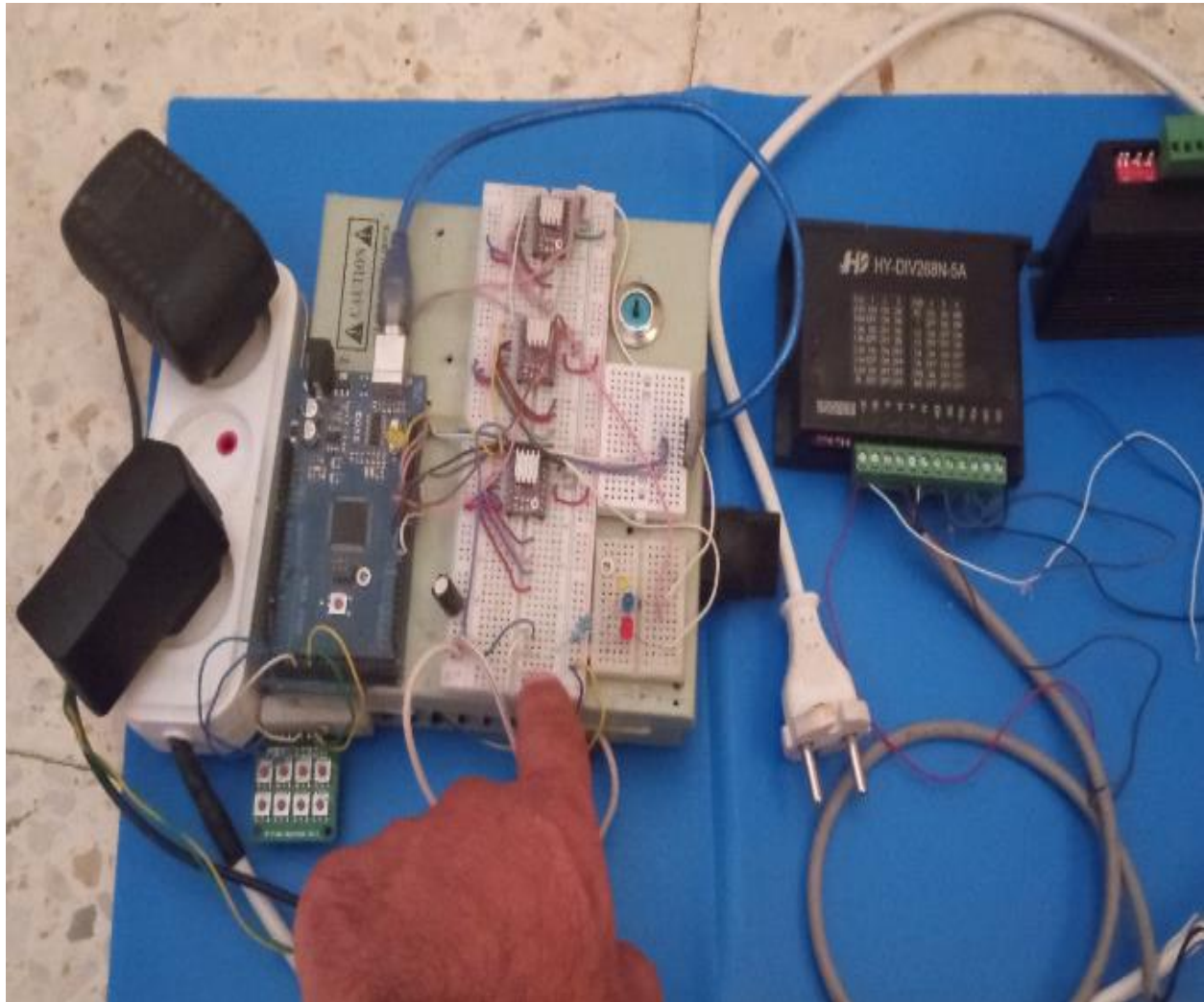
Figure.IV.34 : Câblage réel des éléments électroniques avec les drivers DIV268N
