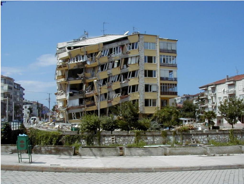
Figure I.2 : Représentation de l'effet d'un séisme sur un bâtiment à Yalova lors du séisme de Gölcük le 17 août 1999 (Turquie). [6]
