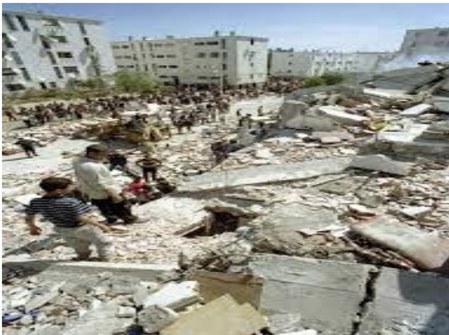
Séisme de Chlef (Octobre, 1980).
