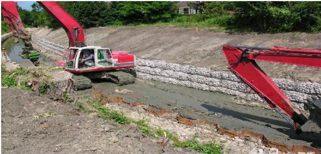
Figure 5.8: Exemple de réalisation d'un mur en gabion
