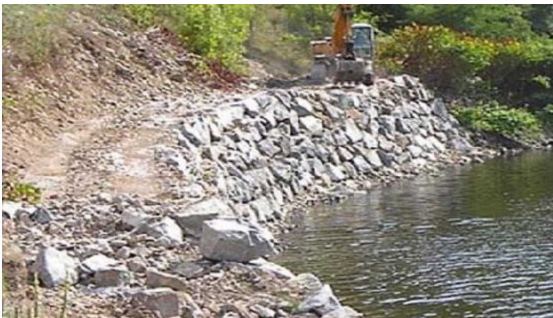
Figure 5.7 : Aménagement avec maçonnerie lors des travaux
