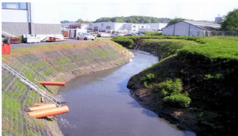
Figure 5.3 : Technique de renforcement des berges à forte pente
