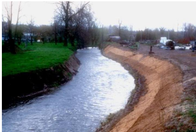
Figure 5. 4: Exemple de réalisation de géotextile
