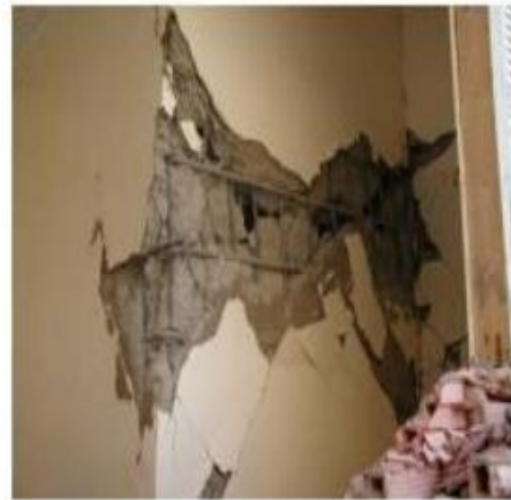
Figure 1.16: Rupture de section à la base des voiles. Figure 1.17: Fissures ouvertes dans le voile.
