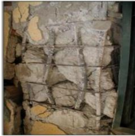
Figure 1.10 : Ecrasement de béton et flambement des aciers dans les deux poteaux de la cage d'escaliers
