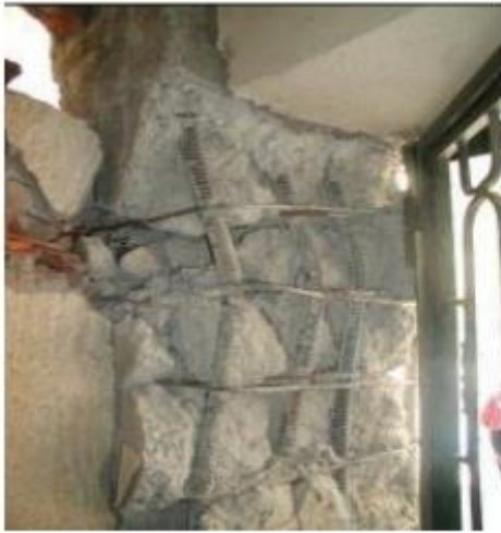
Figure 1.10 : Ecrasement de béton et flambement des aciers dans les deux poteaux de la cage d'escaliers
