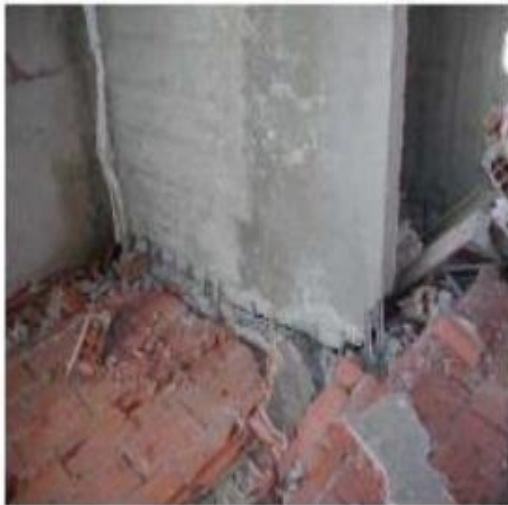
Figure 1.16: Rupture de section à la base des voiles. Figure 1.17: Fissures ouvertes dans le voile.
