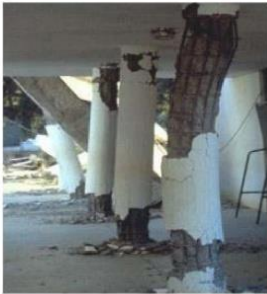
Figure 1.11 : flambement des poteaux
