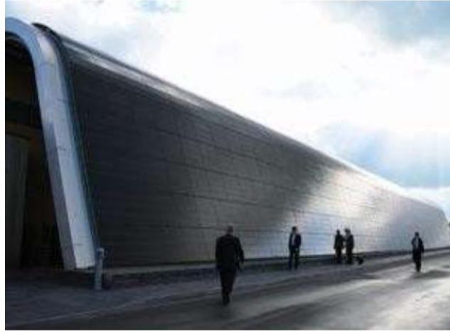
Figure I.9: Façade en CIGS au Pays de Galles, efficacité de 8,5%[12].
