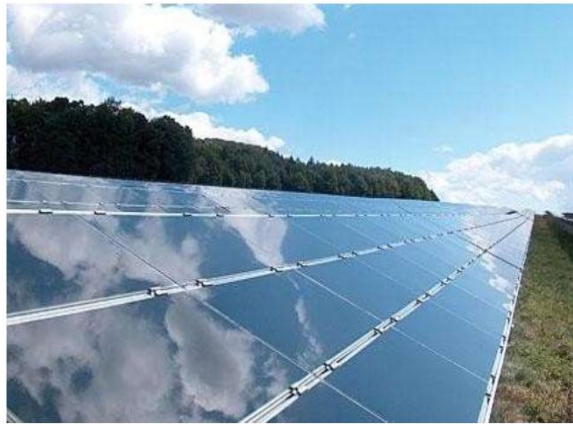
Figure I.8: Modules verre-verre au Telluride de Cadmium CdTe, efficacité de 9 à 11%[12].
