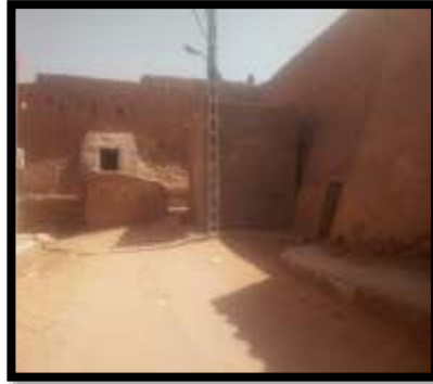
الصورة رقم(14): مدخل قصبة المنجور
