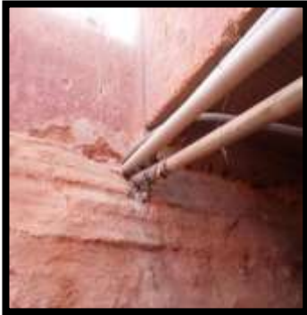
الصورة رقم(21): تصريف المياه
