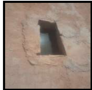
الصورة رقم(19): السواقي لتصريف المياه
