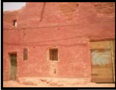
الصورة رقم (07): واجهة معمارية قديمة
