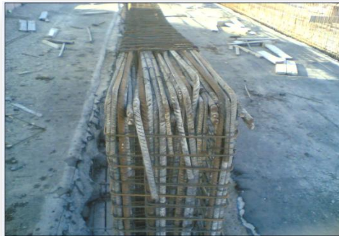
Photo IV-8 : Toutes les barres bateaux ont été relevées aux mêmes endroits ce qui a rendu inefficace leur destination.
