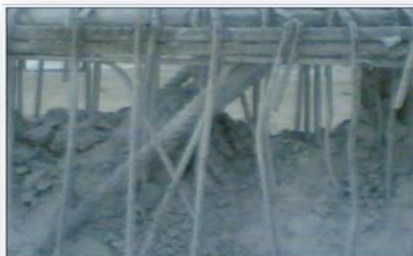
Photo IV-6 : Commencement de la démolition de la poutre après la décision de CTC à cause l'insuffisance dans le ferrailage accentuée par un qualité amoindrie du béton, la démolition de poutre se fait sans toucher le plancher.
