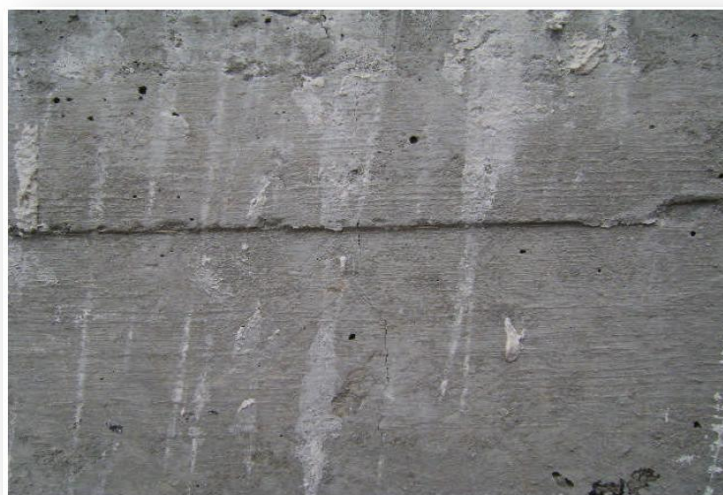
Photo III-4 : Rupture du mur au niveau de l'ouverture selon une direction privilégiée.
