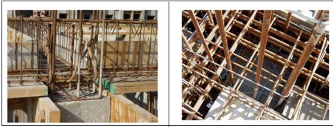
Photo I-5: reprise de bétonnage.
