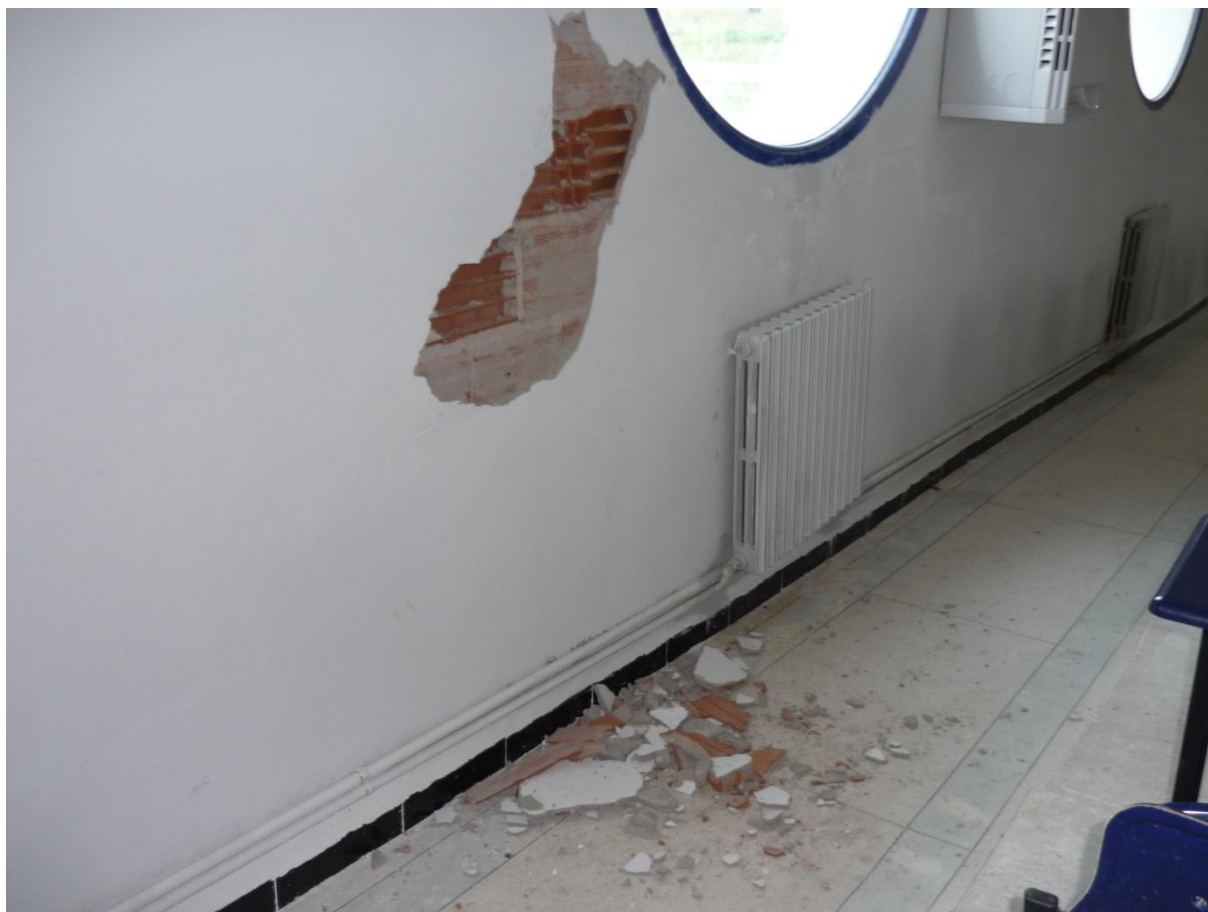
Photo III-4 : Rupture du mur au niveau de l'ouverture selon une direction privilégiée.
