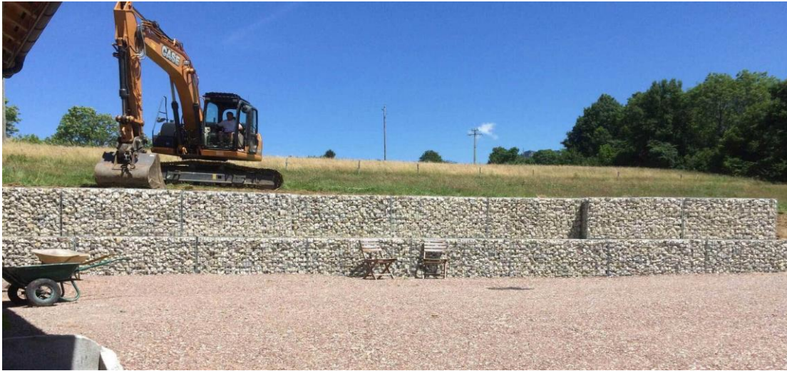
Figure 6. 5: Exemple en gabion
