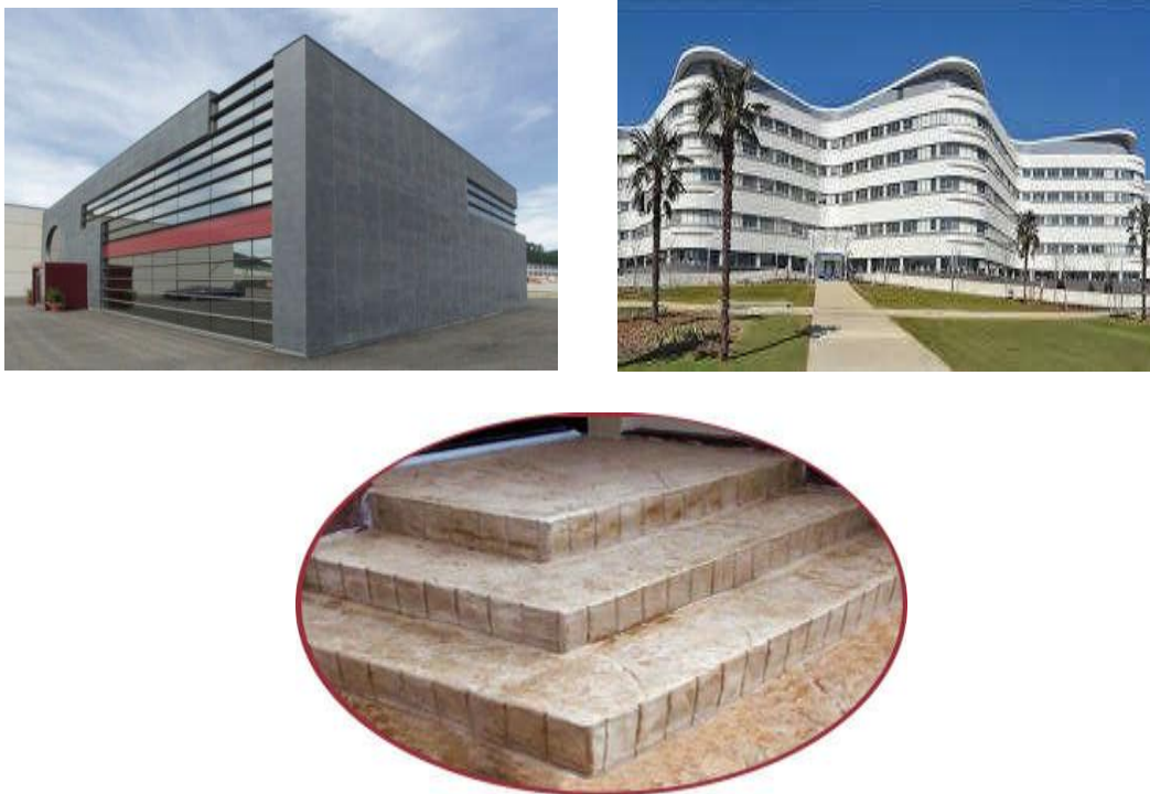
Figure. III.3: Façades et marches d'escalier en béton polymère pour bâtiment.
