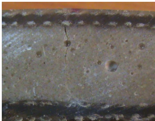
Figure .V.6 : Faciès de rupture du BP-45
