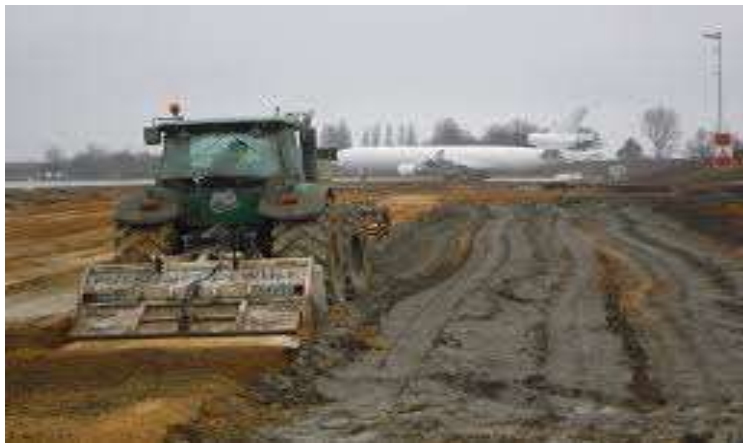
Figure I .4 : Traitement des sols au Ciment
