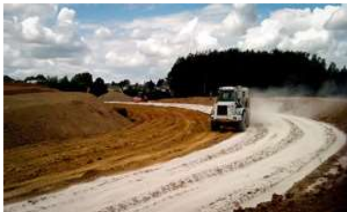
Figure I .3 : Traitement des sols a la chaux
