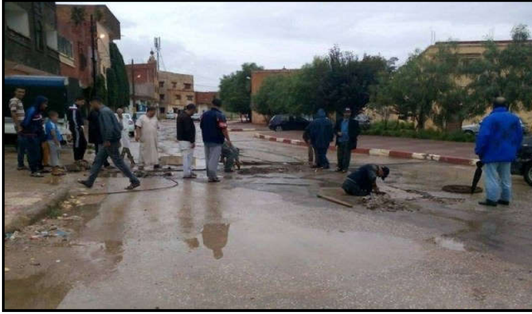
صورة رقم (07) : انسداد قنوات شبكة صرف المياه بوسط المدينة.
