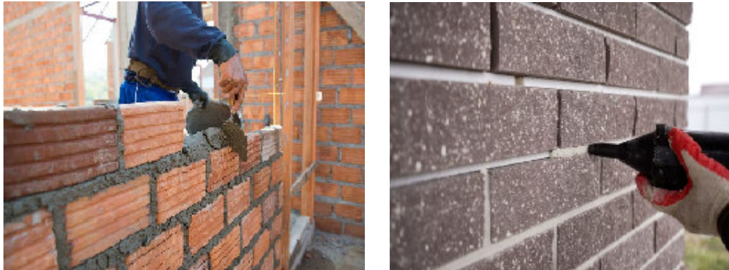
Figure 1-11: Le mortier joint de maçonnerie.[12]
