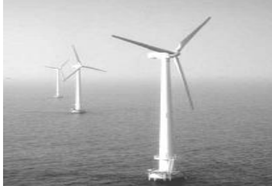
Fig I.10: Éoliennes offshores de Middelgrunden (Danemark).
